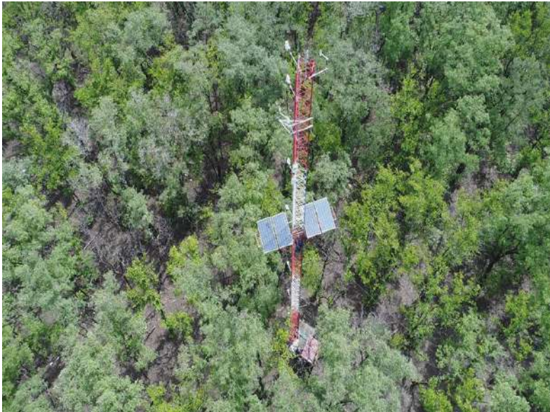
Figura 8. Vista aérea de la Torre de Medición, ubicada en el Manglar Juan Díaz
