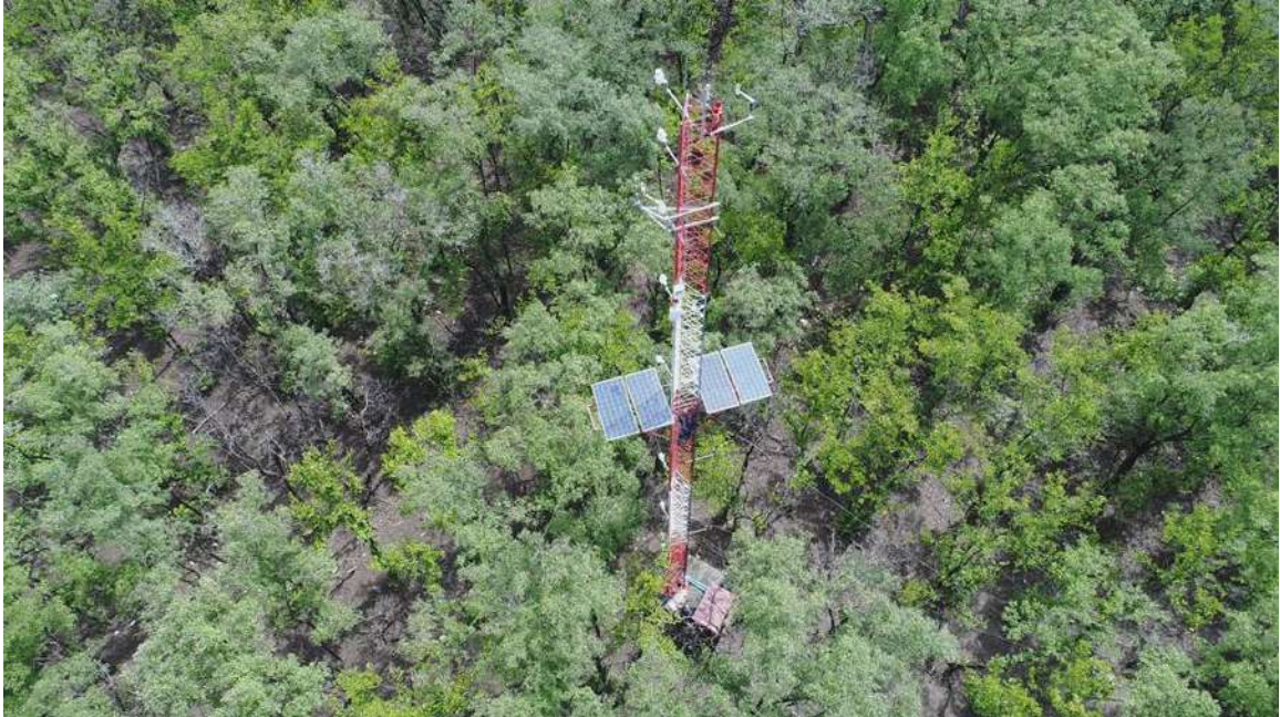
Figura 29. Vista aérea de la torre Jay Zieman. Elaborada por: CIHH.
